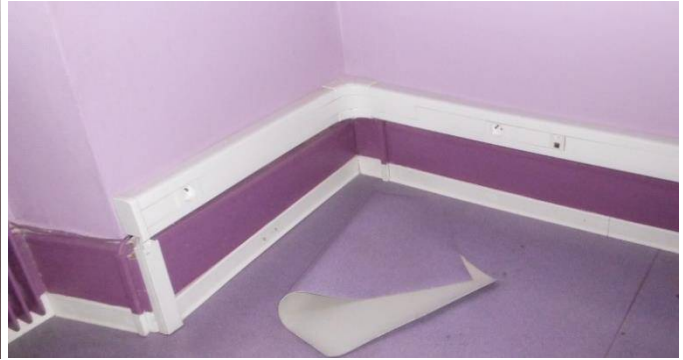
Distribution par goulotte en plinthe
