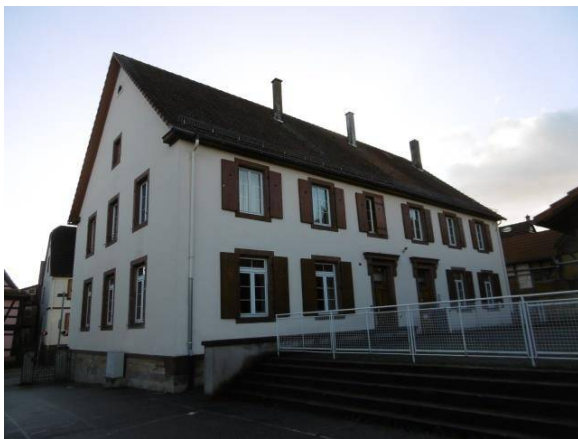
Façade Nord (côté cour)
