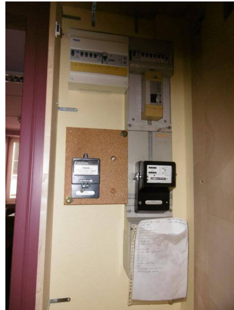
TGBT du logement au 1 er étage
