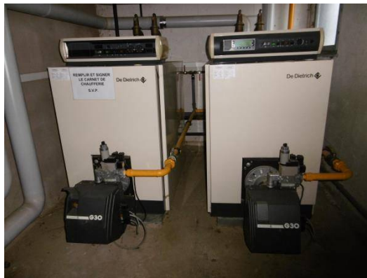
Equipements en chaufferie
