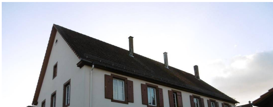
Toiture versant NORD avec souches débordantes
