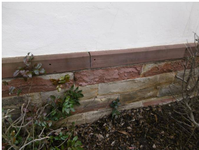
Délitage de la pierre de soubassement en façade SUD
