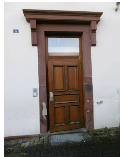
Encadrement de porte réparé
