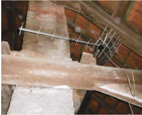
Antenne hertzienne sous combles
