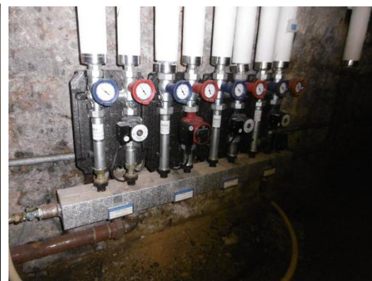
Sous-distribution du bâtiment A (manque les demi-coquilles de calorifugeage des panoplies de distribution hydraulique)
