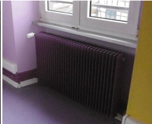
Radiateur avec tête thermostatique
