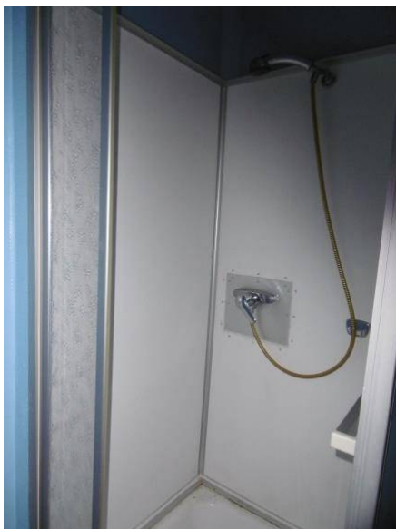
Cabine de douche du logement
