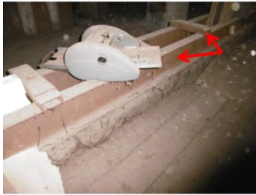
Renfort métallique visible au droit d'une poutre bois dans les combles
