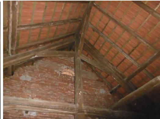
Vue d'ensemble d'une ferme de charpente côté mur pignon
