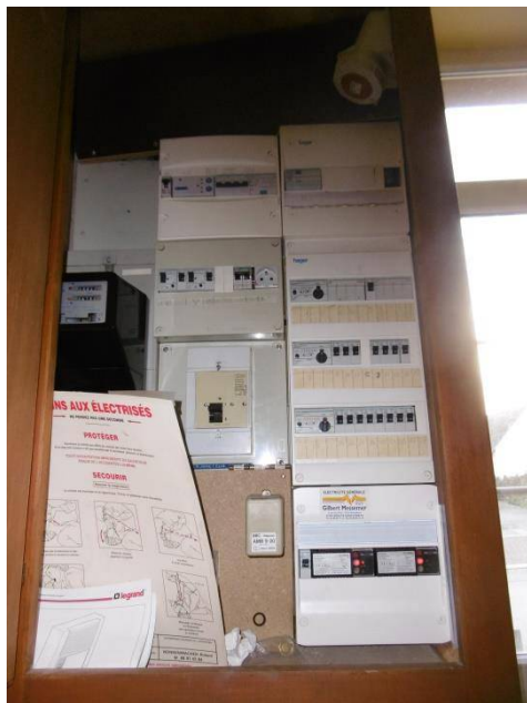
TGBT au rez-de-chaussée
