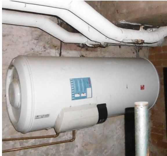
Ballon présent au sous-sol (conduites ECS non calorifugées)
