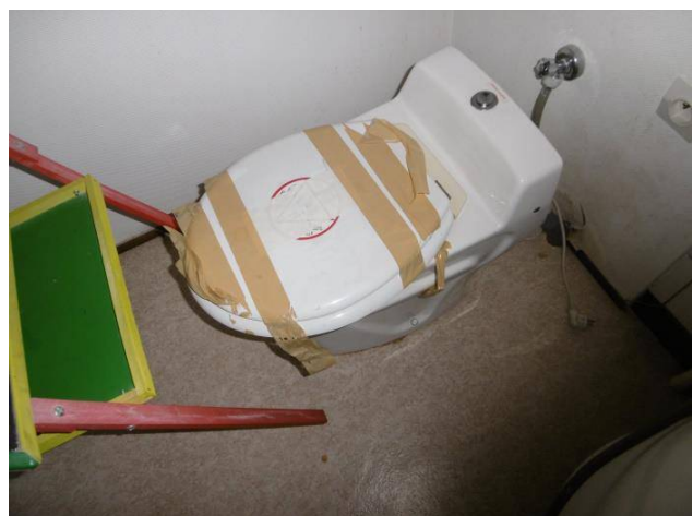
WC type sanibroyeur condamné dans les locaux bureaux
