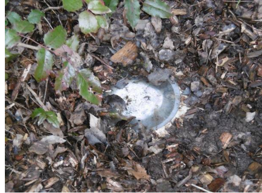
Eclairage extérieur de façade
