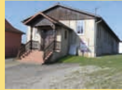
La commune subventionne les travaux de mise en conformité du foyer paroissial de Schwabwiller à hauteur de 14 724€ sur 3 ans
