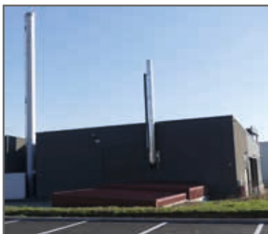
La nouvelle réglementation impose la pose d'un filtre à particules sur la cheminée de la chaufferie - 120 000€
