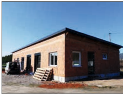
Un réseau autonome d'assainissement sera installé au profit de l'association de pêche - 20 000€
