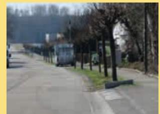
Réhabilitation de la rue de l'Industrie.
