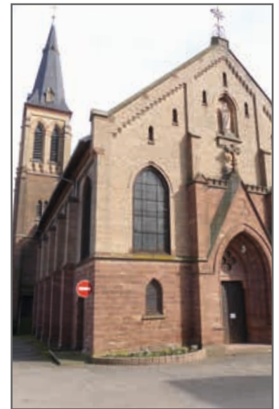
Travaux intérieurs église St Jean (peinture, sonorisation, luminaires) 46 500€
