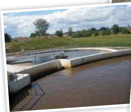
> Vue sur les installations de traitement
