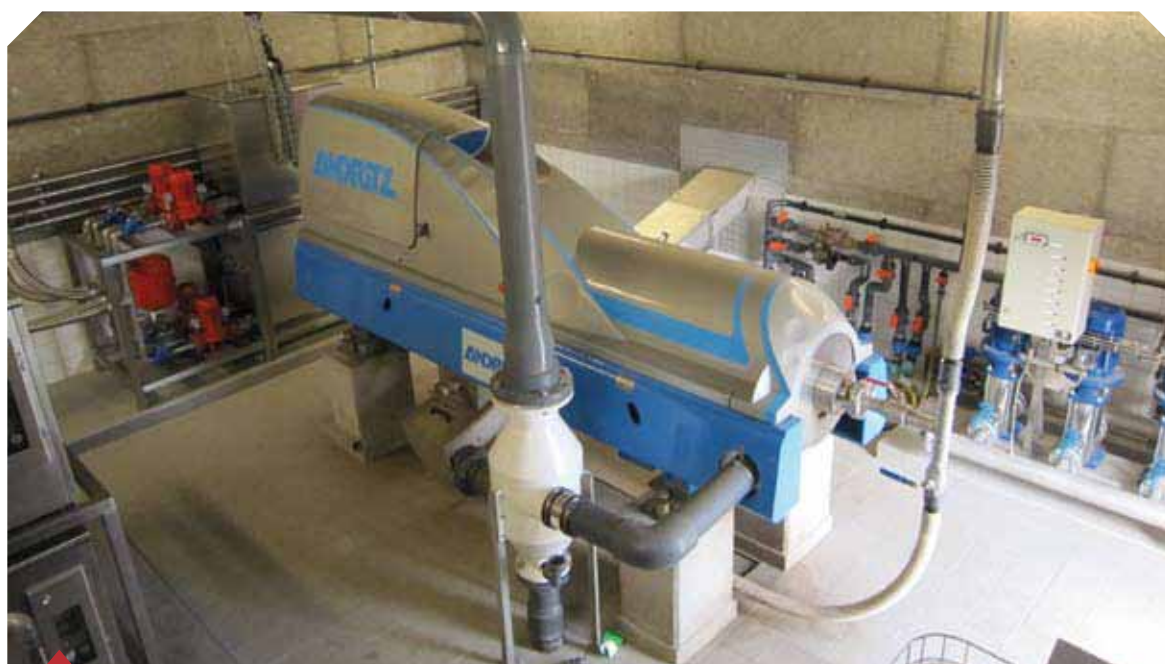
Exemple d'une centrifugeuse avec vis de convoyage des boues.
